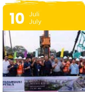
ACSET Lakukan Groundbreaking Simpang Susun Bitung KM25
